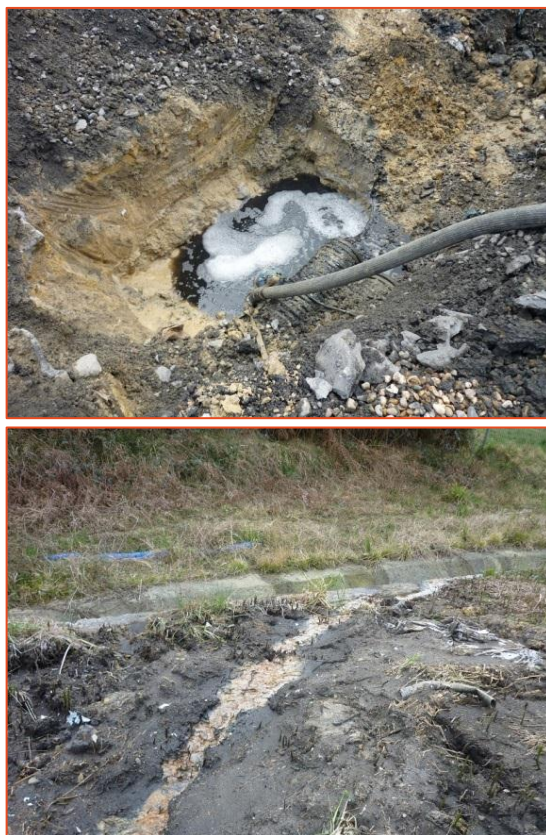
17a eta 17b argazkiak - Ponpen bidez ebakutatutako lixibiatuak zabortegian eta perimetroko ubide baterantz doazen lixibiatuak
