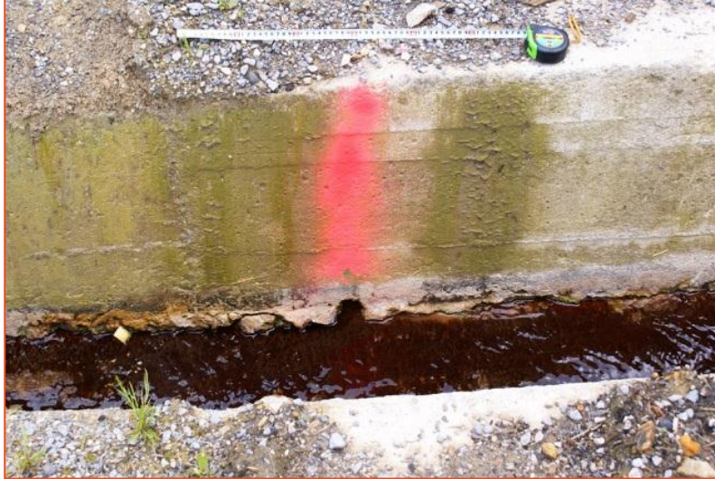
18. argazkia - Lixibiatuentzako hodi bateko ihes-puntua. Kasu honetan, kontroleko emari-neurgailuaren aurretik dago; hortaz, galera honek balantze hidrikoan parte hartzen du.
