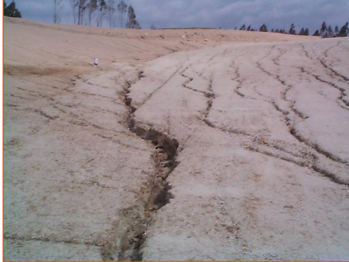
6. argazkia - Hondakinen gaineko ezponda ez-iragazgaitz batek sortutako lurrazaleko jariatzearen aztarnak
