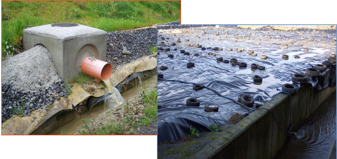
14a eta 14b argazkiak - Gune iragazgaitzetan sortutako lurrazaleko fluxuaren albo-ebakuazioa (behin betiko zigilatzea ezkerrean eta behin behineko estaldura eskuinean)
