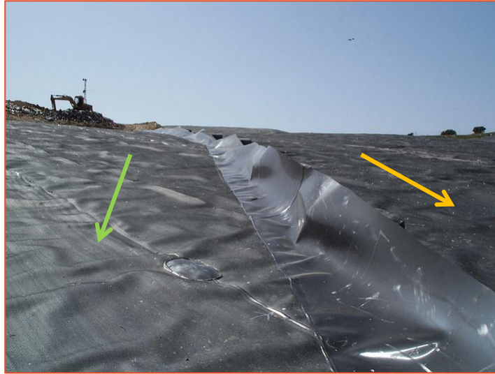
3. argazkia - Hondoa iragazgaizteko kokatutako «rain-flap», zabortegei barruko sektoreak hidraulikoki bereizteko.
