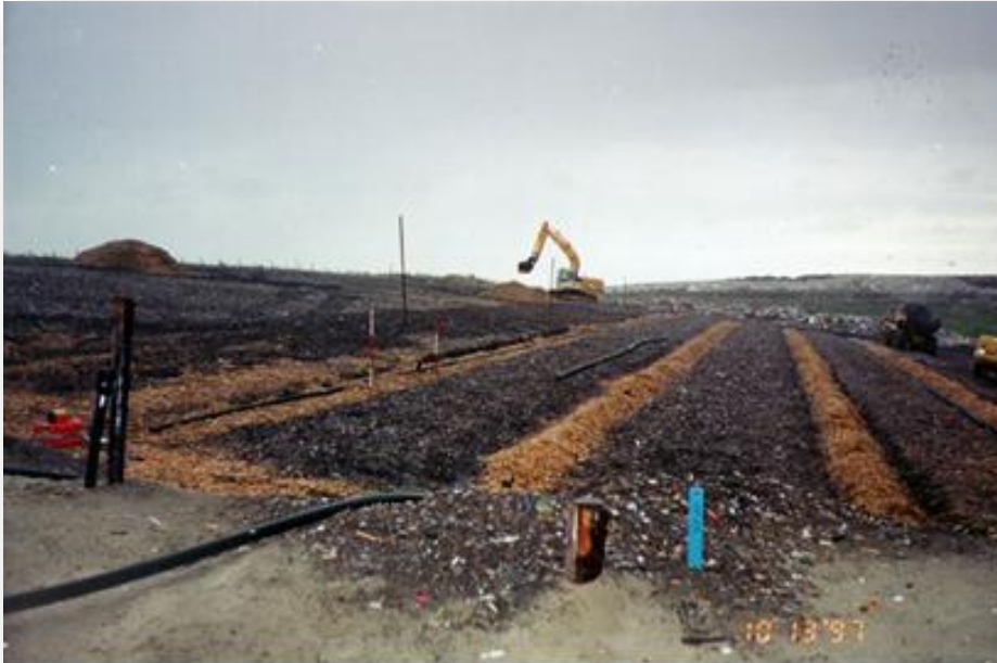
GRÁFICO 5-1. ZANJAS HORIZONTALES
