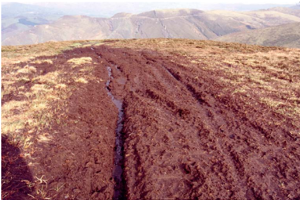
Figura 19.- erosión y acanaladuras producidas por la circulación de vehículos en la “periferia oriental”, en el punto que el camino abandona la turbera.
