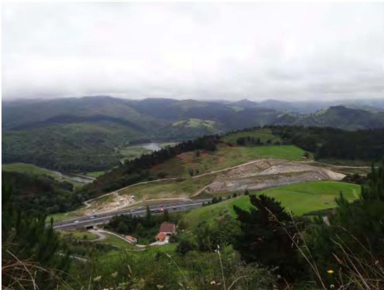
Figura 19: Desmontes en el trazado de la A-8 a su paso por Orio. Se prevé la ampliación mediante un tercer carril.
