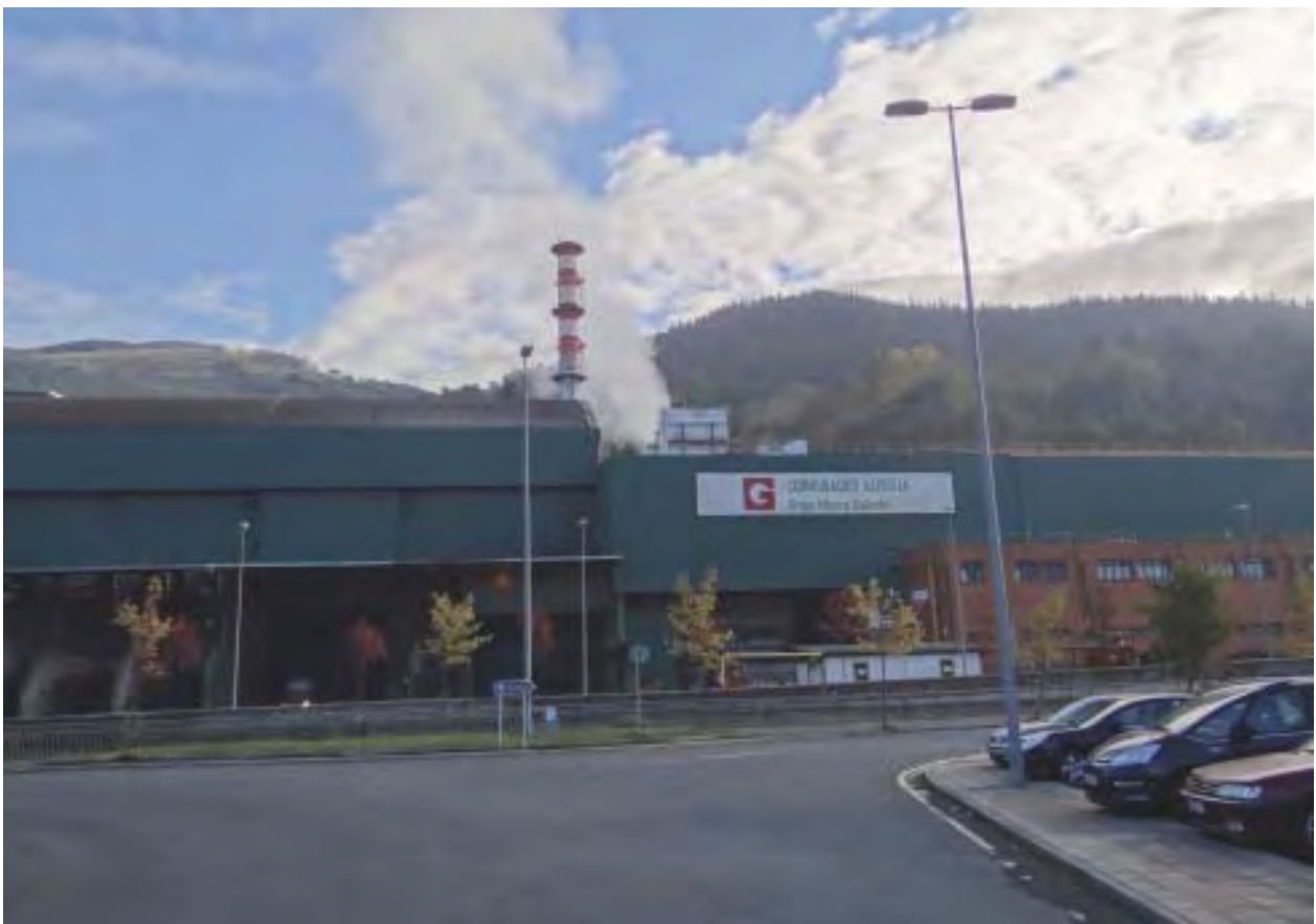
Figura 8: Instalación industrial de Corrugados Azpeitia.
