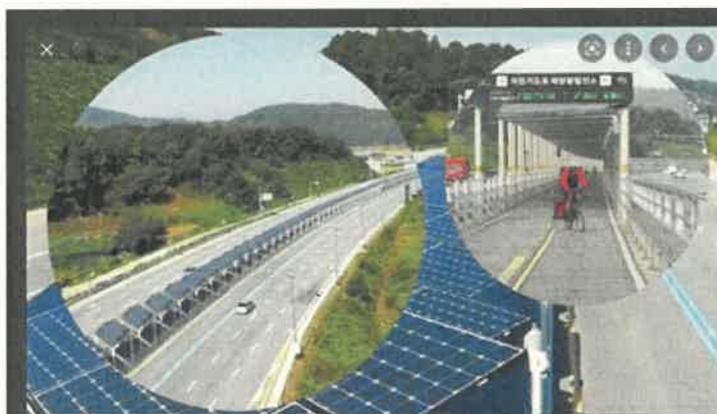
Cubrición de Carril Bici con placas fotovoltaicas.
