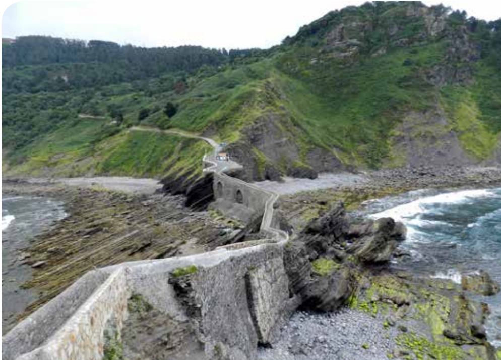
Puente sobre rocas de la serie turbidítica que une la isla al continente. Hay un pequeño aparcamiento hoy en día inaccesible al tráfico rodado. Se puede ver la pequeña rasa a ambos lados del puente.
