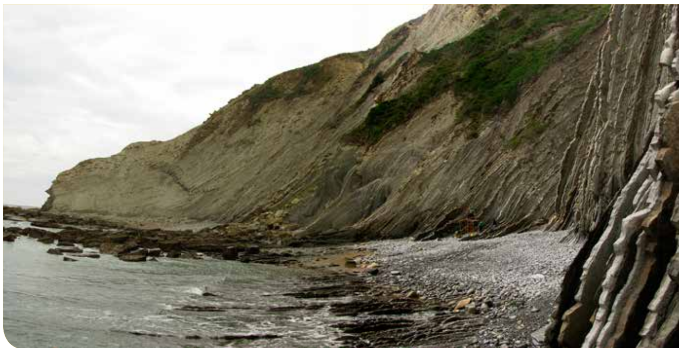
Playa de cantos, acantilados, bloques caídos y desprendimiento de la zona de Itzuruntxiki.
